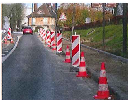
Exemple de balisage d'un chantier fait par nos équipes pour réaménagement de trottoir
